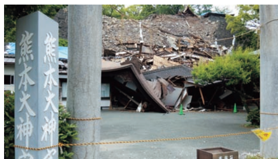
<熊本城の崩壊した櫓と石垣に押しつぶされた熊本大神宮>
