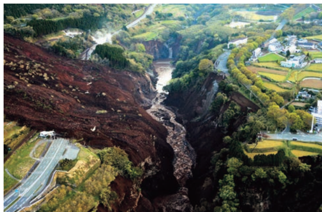
崩落した阿蘇大橋と国道57号線
